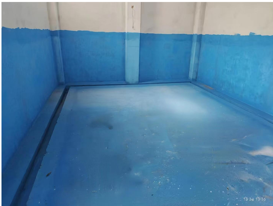
危废暂存间地面及墙面防渗
